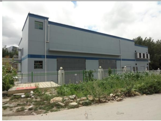
朱家湾变电站
