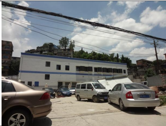
火车站变电站
